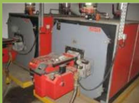
2 Caldaie a metano (1070KW cad.)
